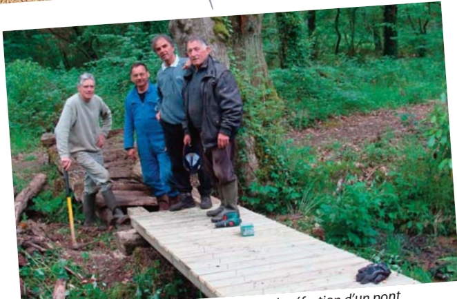
une collaboration entre élus et l'ASPP pour la réfection d'un pont
